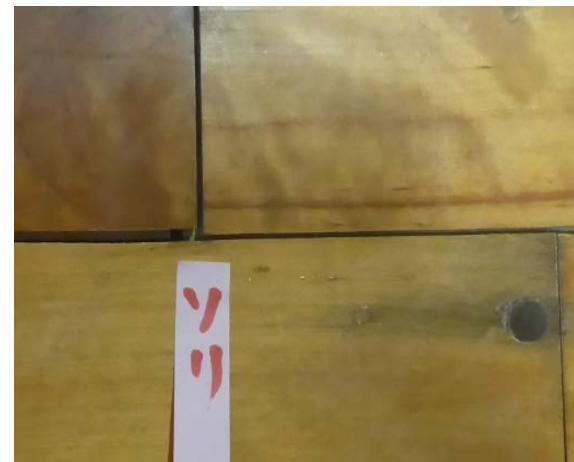
写真 7 目隙(長さ 590mm、幅 3.9mm)、
