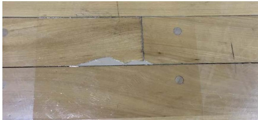
写真 5 パテによる補修例
